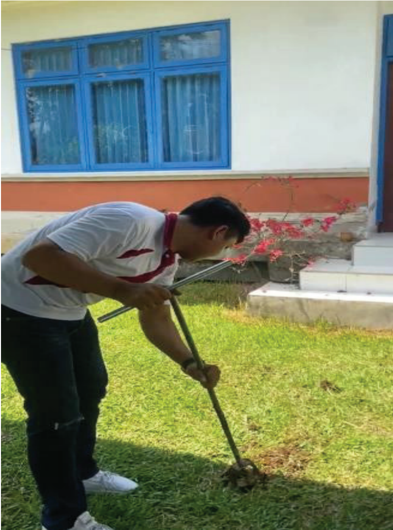
Gambar 4.4 Pemasangan Biopori Di Puskesmas Desa Abuan
