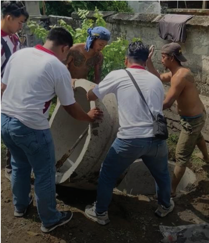
Gambar 4.6 Pemasangan Teba Modern
