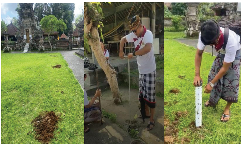
Gambar 4.5 Pemasangan Biopori Di Pura Dalem Sari Desa Abuan
