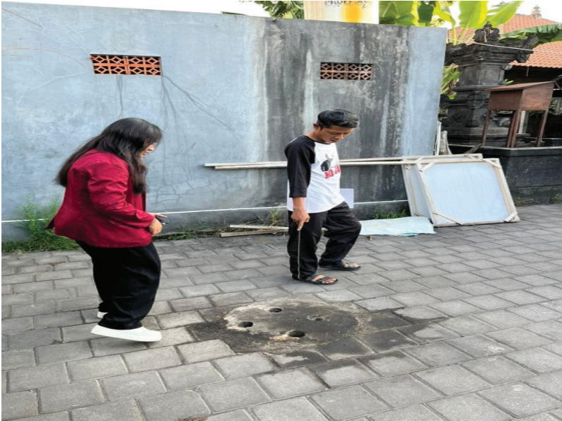
Gambar 3.5 Lubang Biopori Milik Warga
