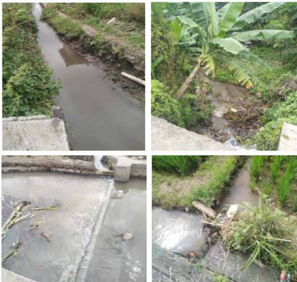
Gambar 3.4 Keadaan Jaringan Irigasi Subak Mambal
